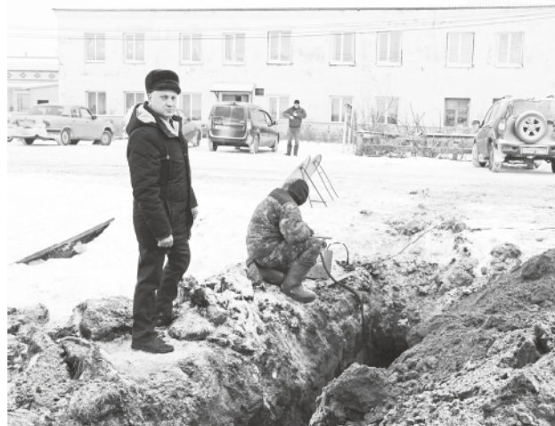
С.М. Спирин инспектирует строительство газопровода.
